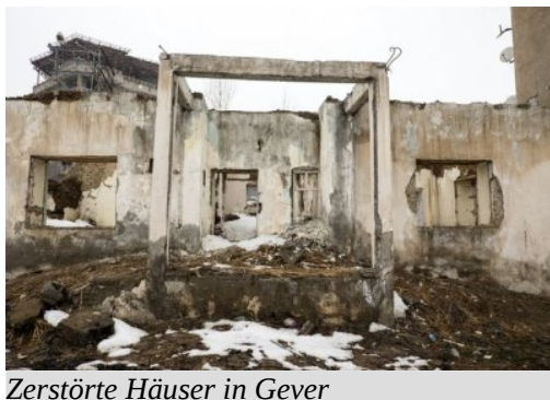
Zerstörte Häuser in Geve
